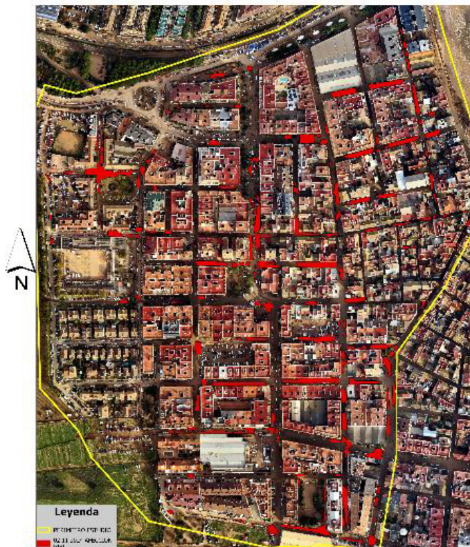
IMAGEN RPAS UME 02-11-2024. Se observa una obstrucción generalizada de los viales.
