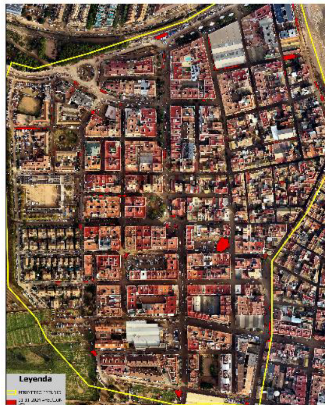
IMAGEN RPAS UME 11-11-2024. Se aprecia apertura de viales con posibilidad de tránsito generalizada. Se observan escombros residuales.
